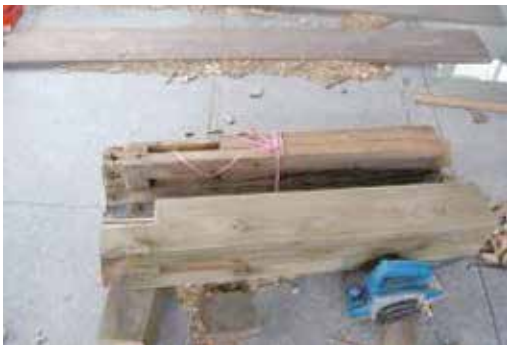
圖59：木構件樁孔補修清理
