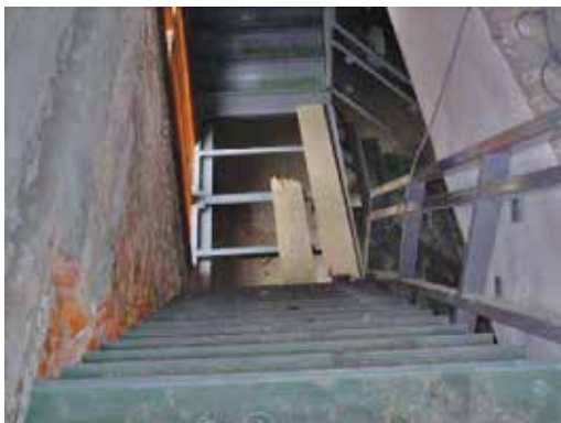
圖101：鋼樓梯組裝施工
