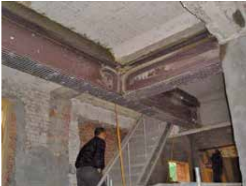
圖93：一樓H型鋼鋼樑補強
