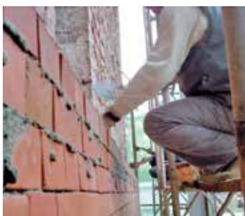
圖24：後側磚牆清水磚疊砌
