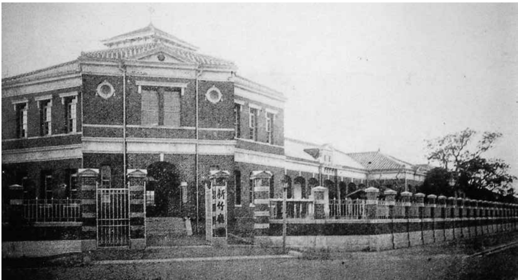
圖2：新設的新竹廳舍外觀
