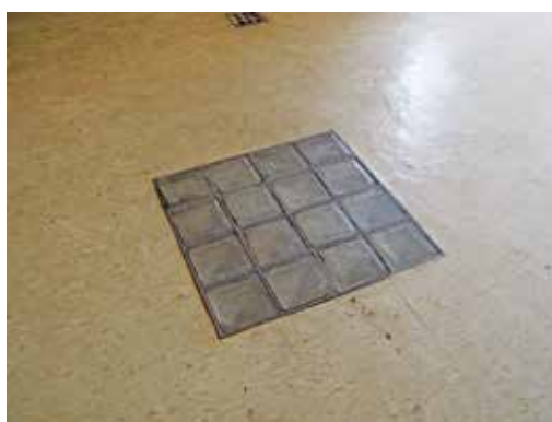
圖32：修復前一樓書庫採光玻璃（上方）
