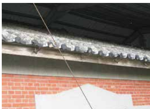
圖8：市役所屋簷殘存的排水天溝舊件
