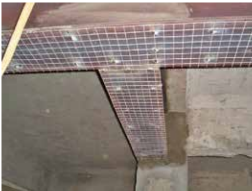
圖95：補強H型鋼表面包覆矽酸鈣板
