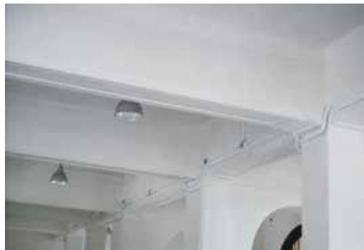
圖46：一樓梁柱粉刷完成
