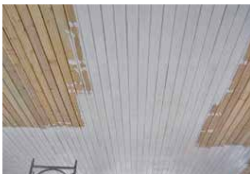
圖52：二樓天花板油漆塗刷
