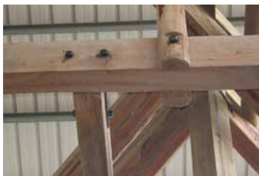
圖62：屋桁與繫件接合緊密
