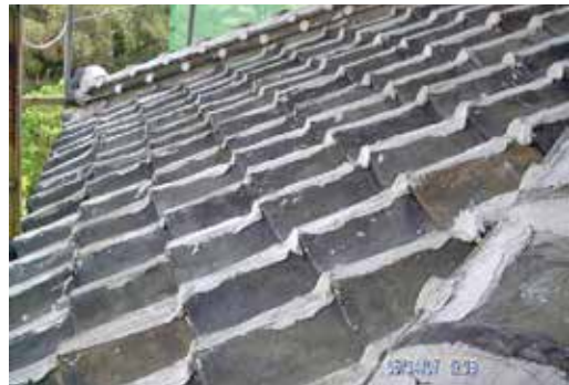
圖74：瓦面接合處填縫處理
