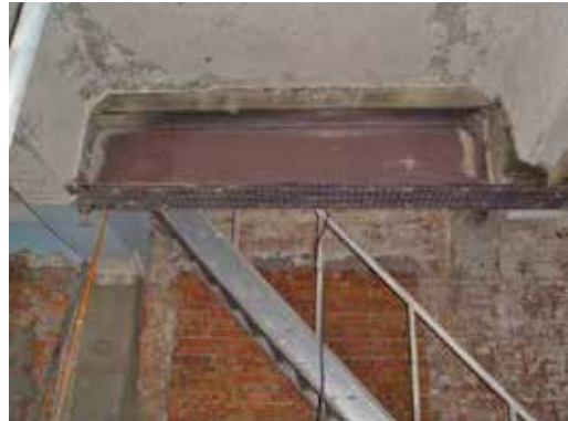
圖94：一樓樓梯處鋼樑
