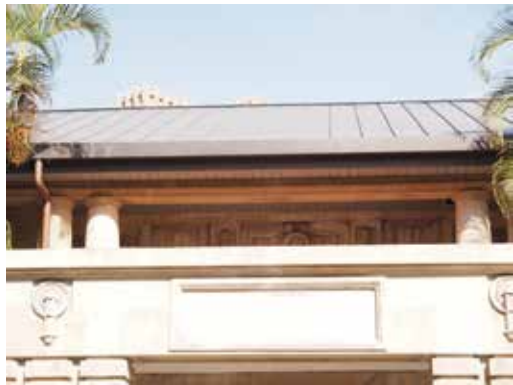
圖25：修復後斜屋頂使用鈦鋅版
