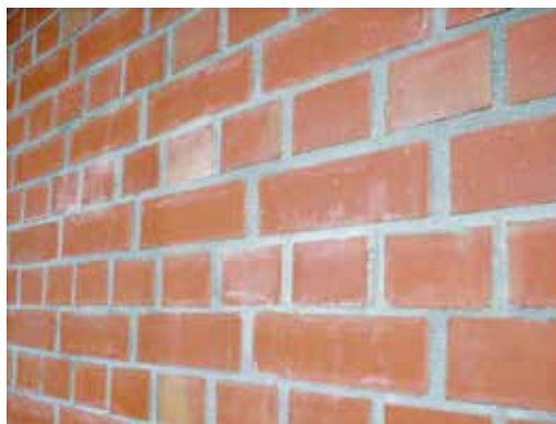
圖28：清水磚砌填縫後
