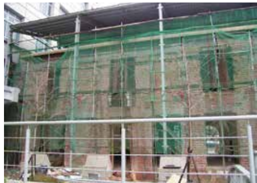
圖21：舊磚牆表面敲除後
