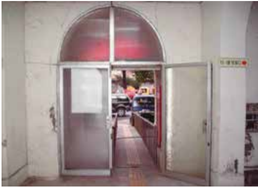
圖15：一樓入口鋁門
