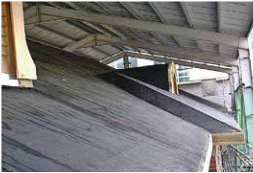
圖103：屋面鋪防水層
