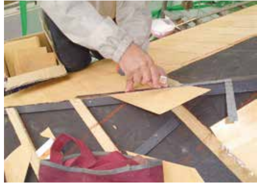
圖116：屋頂檜木皮防水層施工
