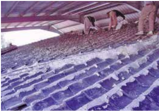
圖67：屋面黑瓦拆卸
