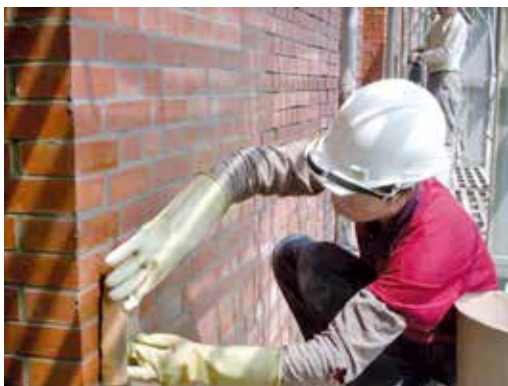
圖27：清水磚砌磚填縫處理
