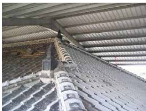
圖76：屋面回鋪完成
