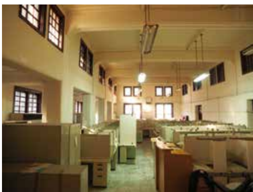
圖29：修復前右側高窗被斜屋頂遮擋
