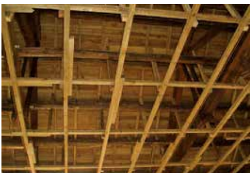
圖49：二樓天花板骨架新作
