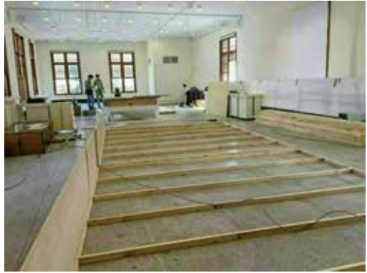
圖23：新竹市美術館佈展照，在木作工程上，需搭建可拆卸、移動並回復原狀的木作隔間以保護館舍牆體。(新竹市美術館提供)
