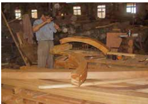
圖79：木窗框加工完成後現場組立
