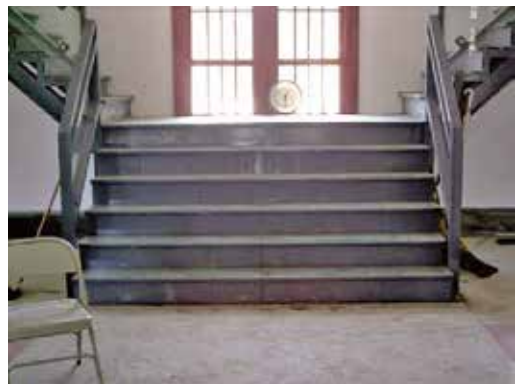
圖102：鋼樓梯完成後正面外觀
