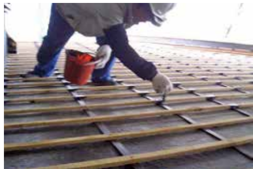
圖106：掛瓦條釘孔補防水漆
