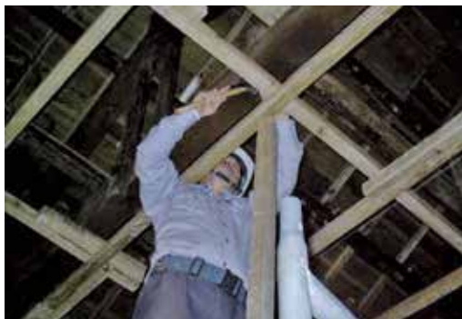
圖48：二樓天花板釘骨架
