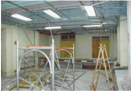
圖41：原有輕鋼架天花板拆除
