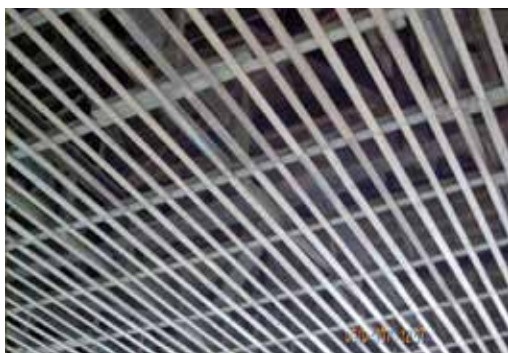
圖50：天花板細角材釘置
