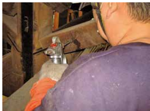
圖86：木構架端部鑽孔灌注
