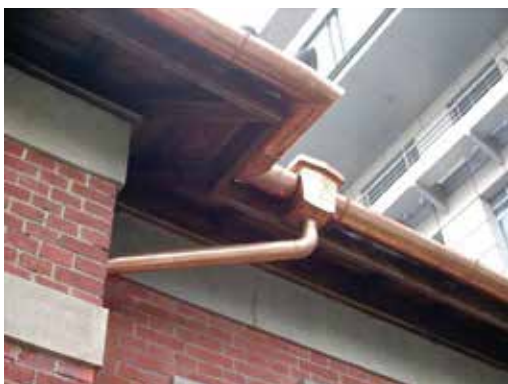
圖77：屋頂銅製天溝 \phi=150\text{mm} 及銅製集水器
