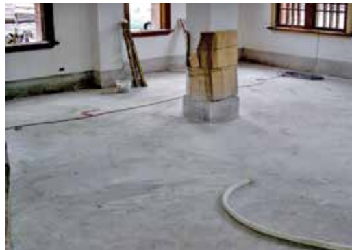
圖35：磨石子地坪底層水泥砂漿打底
