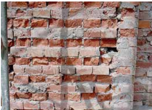
圖20：後側舊磚牆(23×11×5.5公分)局部敲除
