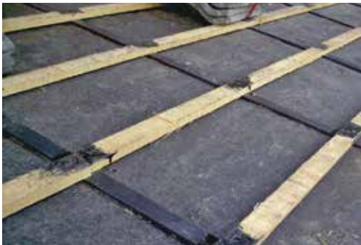
圖107：掛瓦條釘製完成
