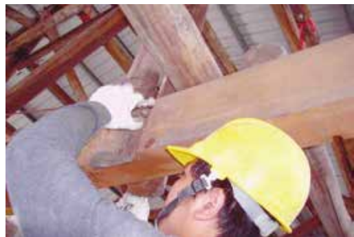
圖56：屋面木構架檢修
