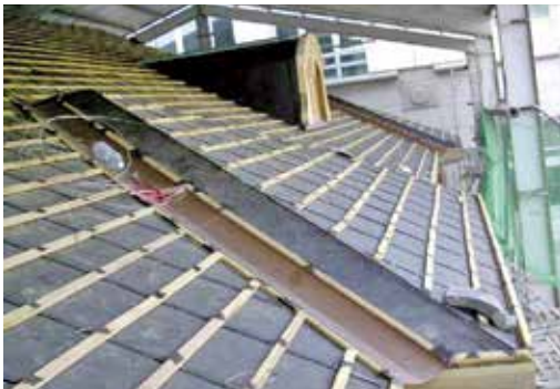
圖71：釘掛瓦條及排水天溝施作
