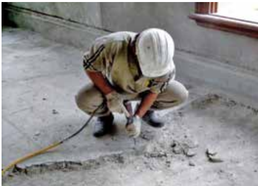
圖34：原磨石子地坪敲除
