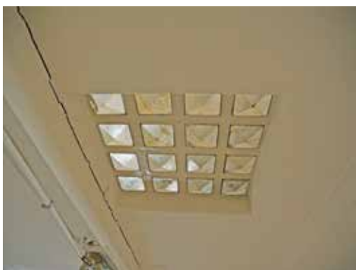
圖31：修復前一樓書庫採光玻璃（下方）
