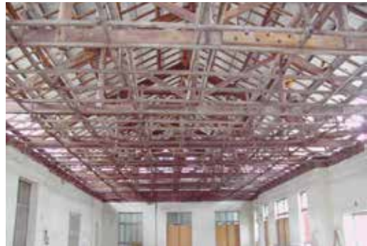
圖54：由下仰視屋面木構架
