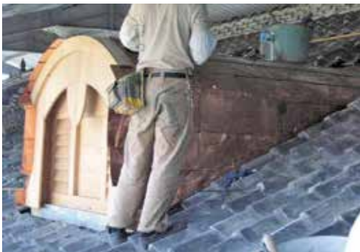
圖69：老虎窗之防水層施作
