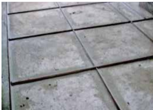
圖37：壓條釘設完成
