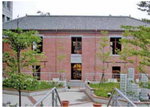
圖33：重砌完成之後側清水磚牆面
