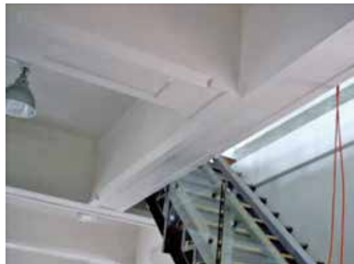
圖96：補強後表面粉刷完成
