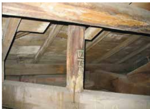
圖10：Ca屋架修復前狀況
