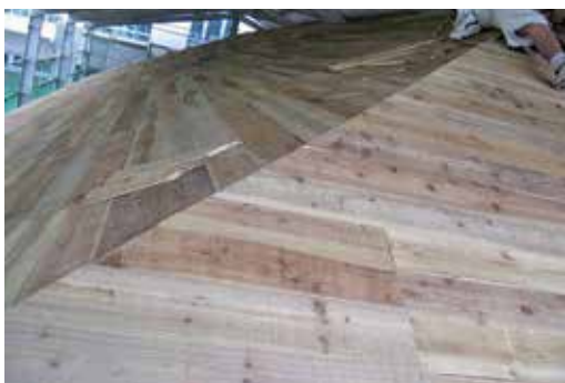
圖65：企口板轉角坡面接合
