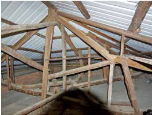
圖22：修復前斜屋頂屋架
