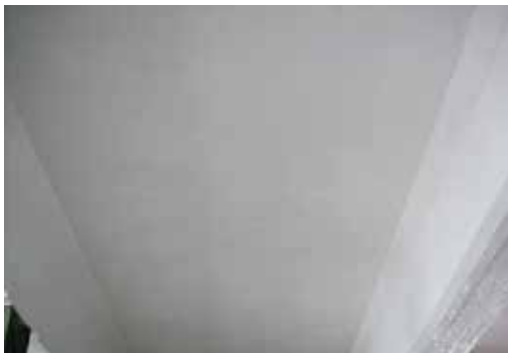
圖45：一樓天花板粉刷完成
