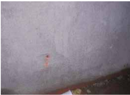
圖89：距地基約30cm高鑽孔
