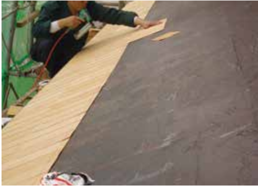
圖115：屋頂檜木皮防水層施工
