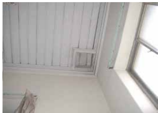
圖14：二樓室內天花板通氣孔保存完整
