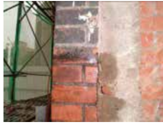
圖30：轉角處磚面清洗中
