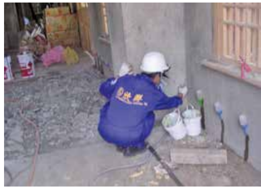
圖90：緩緩注入防潮劑
