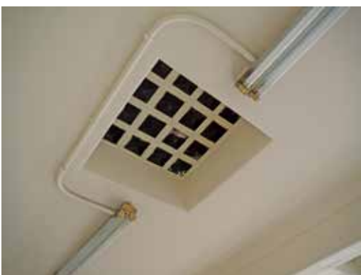
圖33：修復前二樓書庫採光玻璃（下方）
