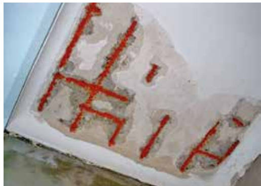
圖92：一樓天花樓板鋼筋作防鏽處理
