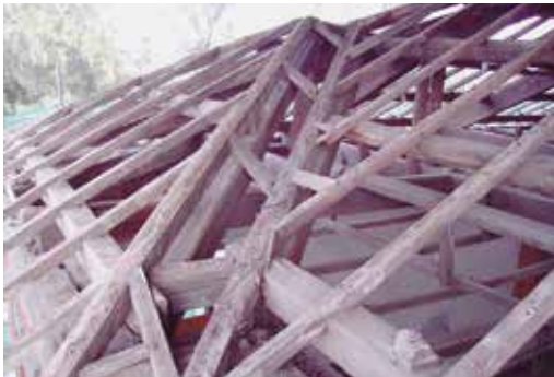
圖53：屋瓦拆卸後屋面構架現況
