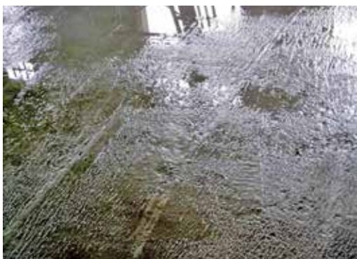
圖38：磨石子材料澆置鏟平
