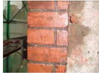
圖31：轉角處磚面清洗後
