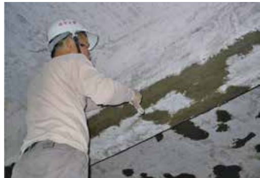
圖44：一樓天花板修補
