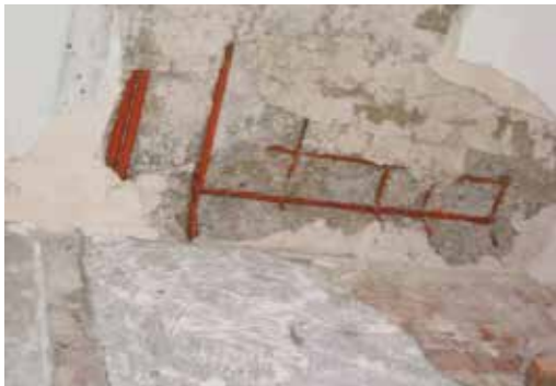
圖43：樓板鋼筋防鏽漆刷塗
