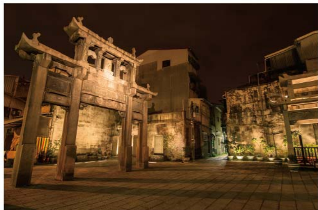
《擎天坊〈接官亭坊〉》中強光電基金會提供
