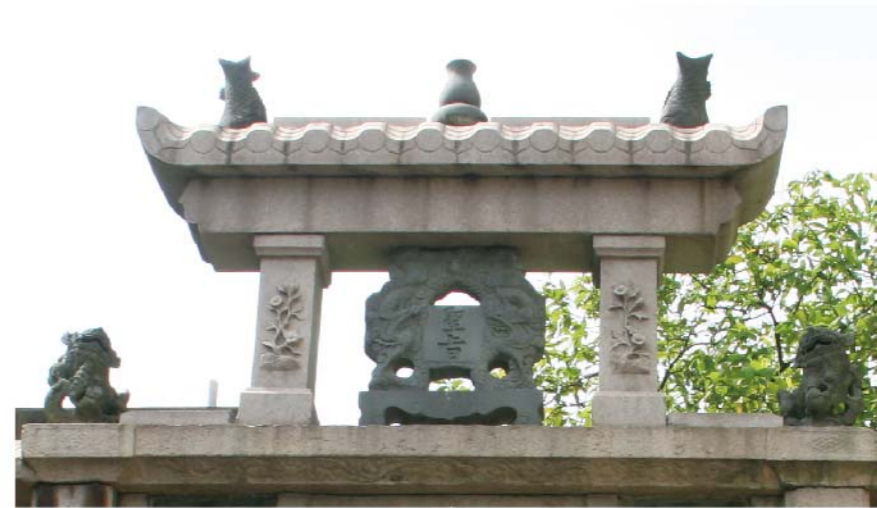
刻有淺雕瓦當滴水的上枋簷，圓雕的葫蘆，透雕的聖旨及短柱的蘭蓮菊梅。
