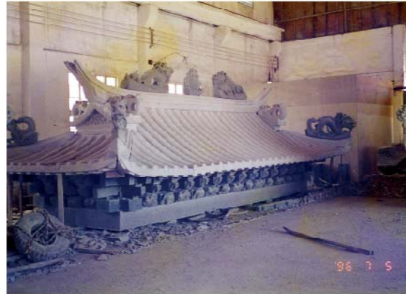
石坊牌樓屋頂配件
