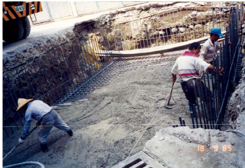
基礎底層鋼筋混凝土
